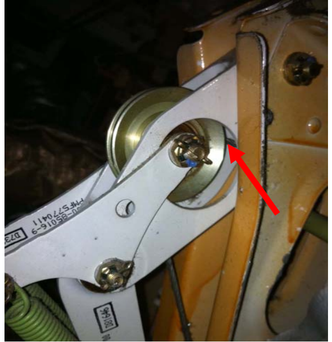
Câble délogé et coincé du système de levier à poulie du système manuel de sortie du train situé sous le plancher.
